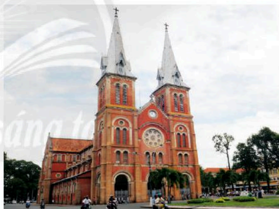
Nhà thờ Đức Bà - Thành phố Hồ Chí Minh, ảnh của Hoàng Chí Hùng
